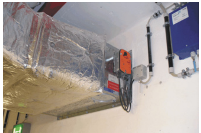
Bild 8: Montage eines Stellmotors an einer Brandschutzklappe K 90 (Ansteuerung über Rauchauslöseeinrichtung)
