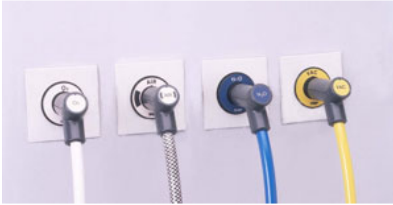
Bild 5: Anschlussmöglichkeit für medizinische Gase (Wandentnahmestellen), Werkbild ©Dräger Medical ANSY GmbH
