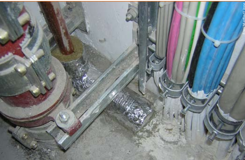
Abb. 1: So eng darf es nicht sein. Die Abstände zwischen Abschottungen wurden vom DIBT neu geregelt.
