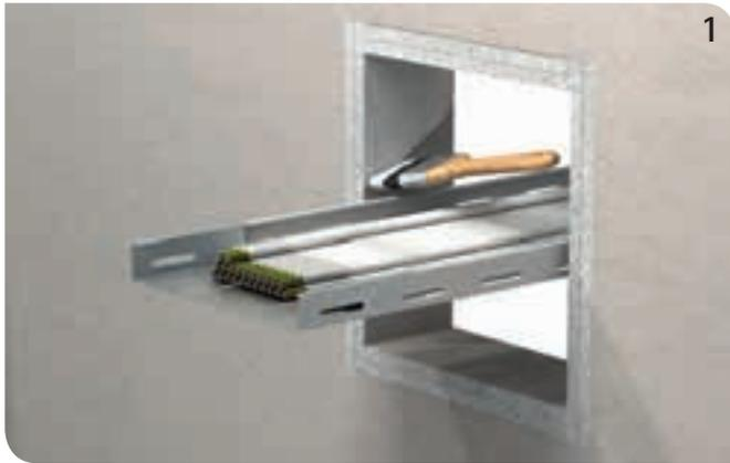
Öffnung reinigen und alle losen Teile entfernen. Öffnungslaubung mit Brandschutzbeschichtung BIS Pacifyre® beschichten.
