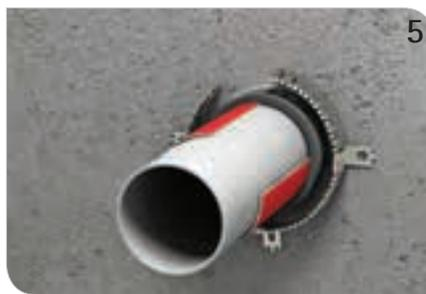
5 Zum Verschluss des Metallbandes 2 Nasen am Ende des Bandes aufbiegen. Beide Enden übereinanderlegen und Nasen zurückbiegen, um Band zu verschließen.
