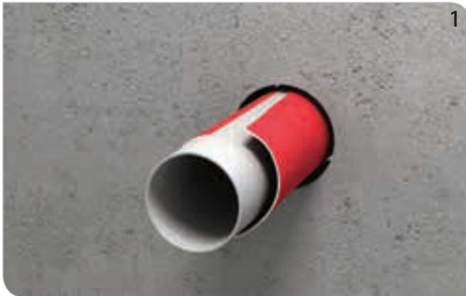
Rohrleitung (ggf. mit Schallschutzschlauch) installieren.
