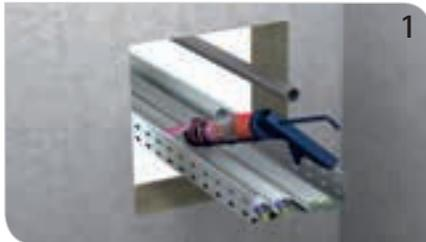
Tangit FP 450 Brandschutz-Paste in Bauteilstärke um und zwischen die Kabel flächig auftragen.
