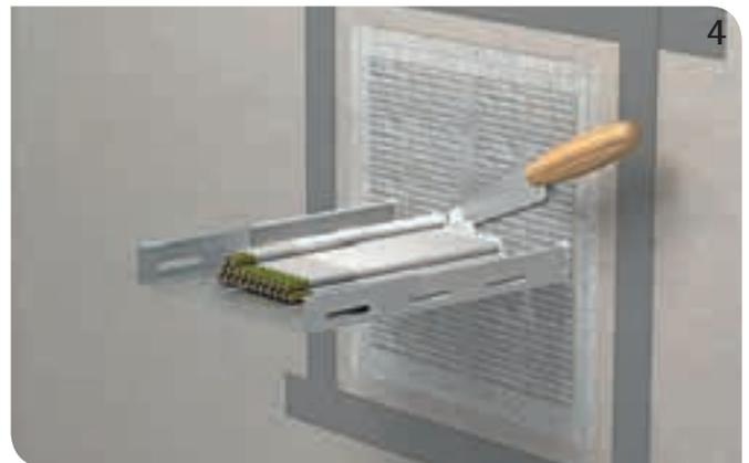
Alle Restfugen/-spalte mit BIS Pacifyre® MP Beschichtung verfüllen und anschließend Bauteilöffnung mit einem Abstand von 2 cm zu den Kanten umlaufend abkleben, um vollflächig beschichten zu können.
