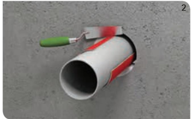
Restspalt rauchgasdicht (mit z. B. BIS Pacifyre® FPM Brandschutzmörtel) verschließen.
