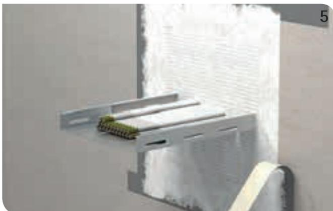
Abschließend die komplette Oberfläche innerhalb der umlaufenden Verklebung mit BIS Pacifyre® MP Beschichtung versehen (Trockenschichtstärke > 1 mm).
