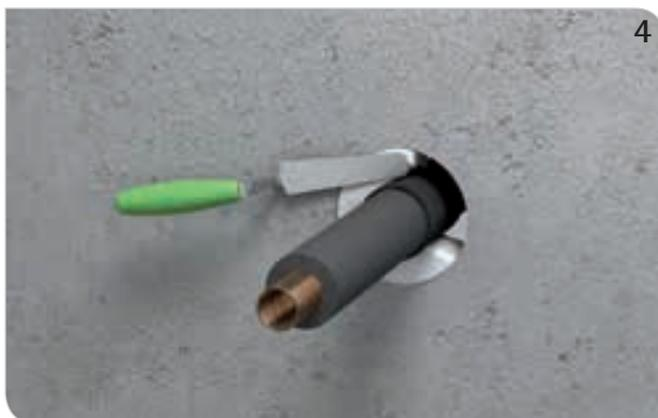
Ringspalt rauchgasdicht (mit z. B. BIS Pacifyre® FPM Brandschutzmörtel) verschließen.
