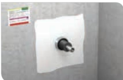
Nicht brennb. Rohr mit brennb. Dämmung.
