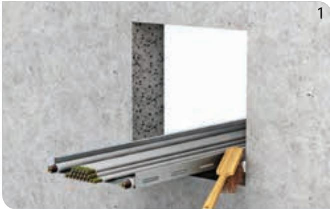
Öffnung reinigen und alle losen Teile entfernen.
