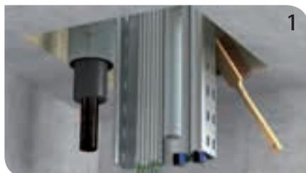
1 Deckenschott säubern und verlorene Schalung z.B. mit Tangit FP 200 Klebeband erstellen.
