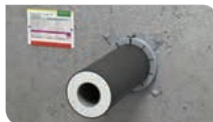
Abschottung von +GF+JRG CoolFit-Rohren bis
