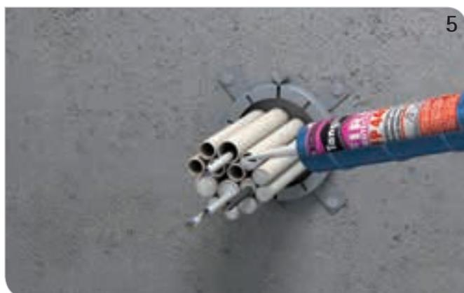
*Die unbesetzten Leerrohre und andere Restöffnungen rauchgasdicht mit z. B. Tangit FP 440 Brandschutz-Fugenfüllmasse verschließen.*
