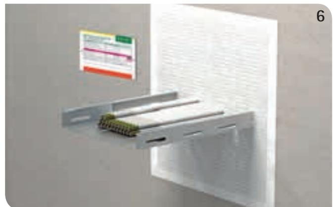
Klebeband abziehen und Kennzeichnungsschild ausgefüllt neben der Abschottung anbringen.
