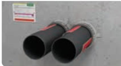
Nullabstand gedämmte Rohre
