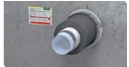
Mehrschichtverbundrohre mit und ohne Synthekautschukdämmung
