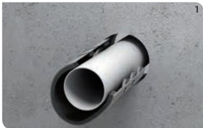
Rohrleitung installieren und Manschettengröße auswählen.
