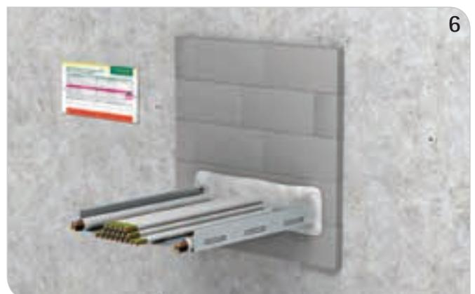
Schott auf Richtigkeit prüfen, Kennzeichnungsschild ausfüllen und neben der Abschottung anbringen.
