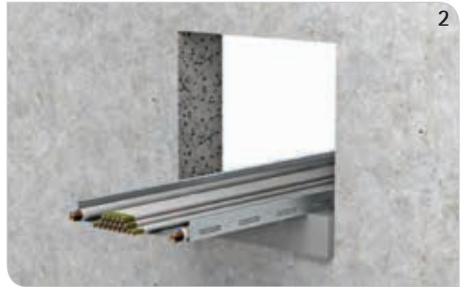
BIS Pacifyre® IWS Brandschutzsteine mit der langen Seite (160 mm) nach vorne in die Öffnung einbringen.
