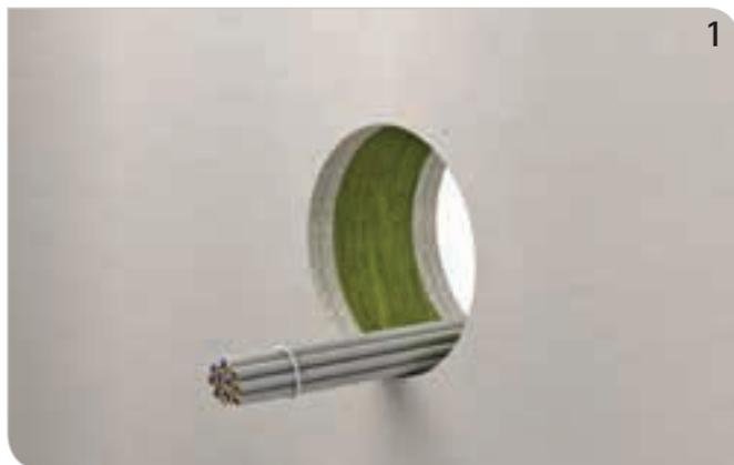
Öffnung reinigen und alle losen Teile entfernen.
