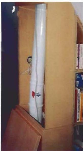
**Bild 6:** Dieses schrankartige Gebilde einer Abgasanlage entspricht sicher nicht der FeuVO. Als Lösung würde die Bauart Bild 5b zur Verfügung stehen.
