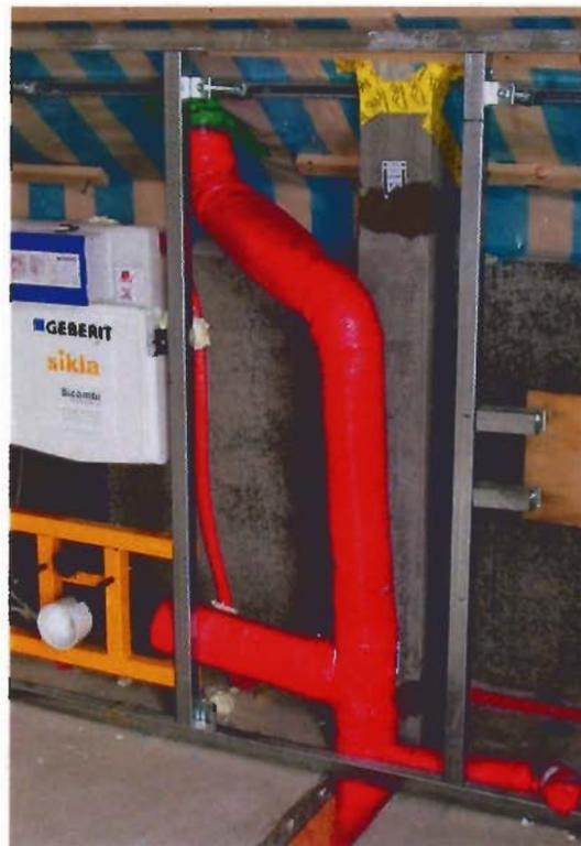
**Bild 13:** Luftdichte Abklebung am Abgasschacht und der Abfluss-Entlüftungsleitung.
