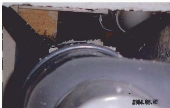
**Bild 3:** Fremdleitungen und brennbare Schachtbaustoffe innerhalb des Schachtes für die Abgasanlage sind nicht zulässig.
