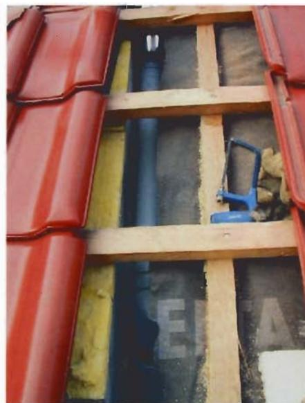
**Bild 7:** Bei diesem Verzug der Abgasanlage innerhalb der Dachkonstruktion fehlt die feuerwiderstandsfähige Einhausung der zugelassenen Abgasleitung. Die Überprüfbarkeit der Dichtheit ist nicht gegeben. Die Anforderungen an die Feuerwiderstandsdauer sind nicht erfüllt. Bei Sonnenbestrahlung des Daches würden an dieser Stelle Spannkraft durch die Ausdehnung auftreten, die zu einer Beschädigung des Rohres führen können (= nicht mehr vorhandene Dichtheit).
