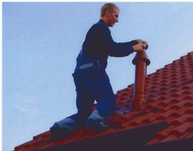
**Bild 4: Dachdurchführung einer Abgasanlage für Raumluft unabhängige Brennwertgeräte.**
