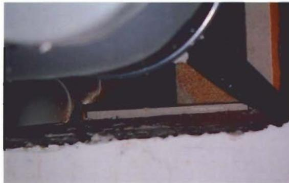
**Bild 2:** Bauseitige „Bastellösung“ eines I 90-Schachtes für eine Abgasleitung“ als Ansicht von unten durch die Betondecke. Für die Befestigung der Calcium Silikat-Platten wurden Holzbalken verwendet. Die Schachtverkleidung wurde stumpf auf die Rohdecke aufgesetzt. Diese Ausführung ist Pfusch und nicht abnahmefähig.
