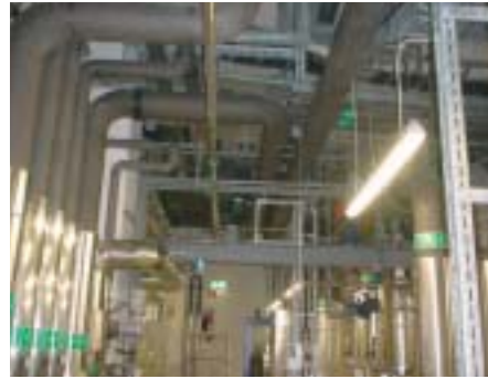
Bild 9: Installation einer Kältezentrale in einem Sonderbau
