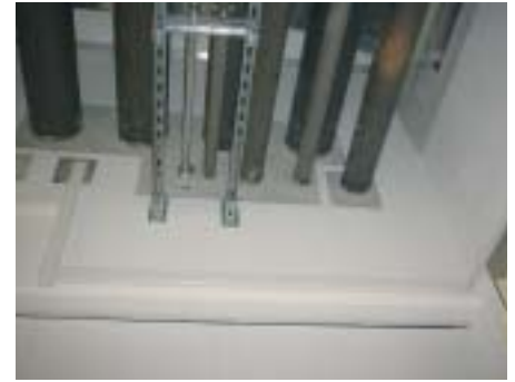
Bild 10: Abschottung von Kälteleitungen mit Pyrostat-Uni unter Beachtung der a.R.d.T.
