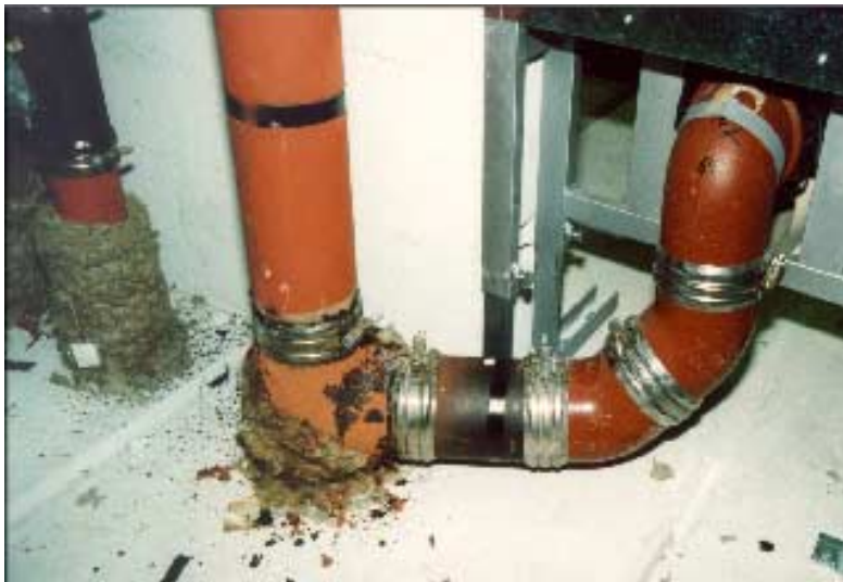
Bild 1: Versuchsaufbau SML-Abflussrohre bei einer Brandschutzprüfung des IBMB, Braunschweig nach 90 Minuten Beflammung im Brandofen unterhalb der Decke
