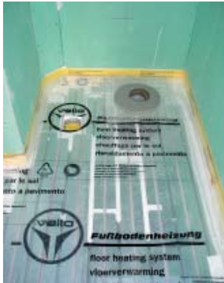
Bild 9: Bodenablauf in einer barrierefreien Duschanlage auf Holzbalkendecke inkl. einer Boden- temperierung.
