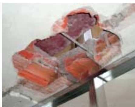
Bild 5: Einbau eines Bodenablaufs R 30 in einer F 30-Hohlkammerdecke.
