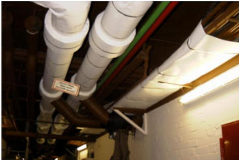
Bild 3: Bandagierte Kabeltrassen und Kälteleitungen aus Stahl mit brennbaren Dämmungen aus synthetischem Kautschuk. (Werkbild GuH-Isolierung)
