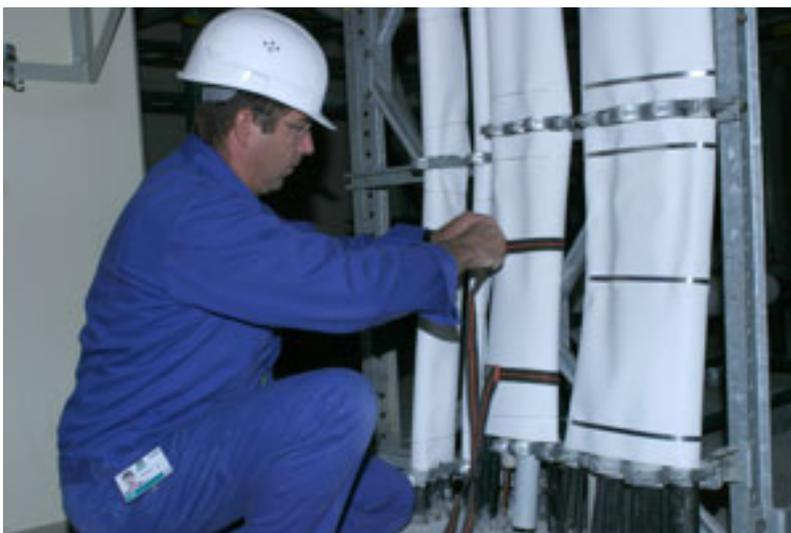
Bild 1: Kabelvollbandage an einer Steigetrasse zur Verhinderung der Brandausbreitung entlang der Kabeltrasse (Werkbild G + H Isolierung)
