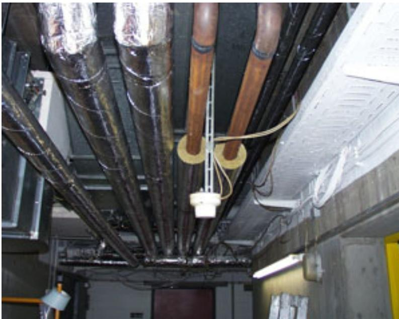
Bild 6: Dämmschichtbildende Kabelschutzbeschichtung im Bereich der Trasse, der Befestigungen und der Einzelkabel auf der Wand (Werkbild MEHLAG)
