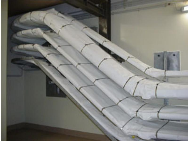
Bild 2: Kabelvollbandage in einem Energiekanal zur Verhinderung der Brandausbreitung entlang der Kabeltrassen im Bereich der Hauptversorgungsstrassen (Werkbild GuH-Isolierung)
