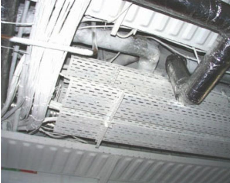
Bild 5: Kabelschutzbeschichtung mit einer dämmschichtbildenden Beschichtung auch im Bereich der Befestigung (Werkbild MEHLAG)
