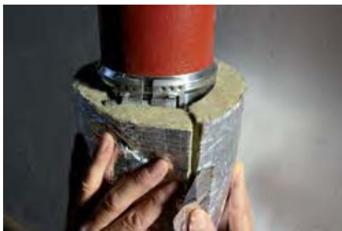
Montage der ROCKWOOL Klimarock
