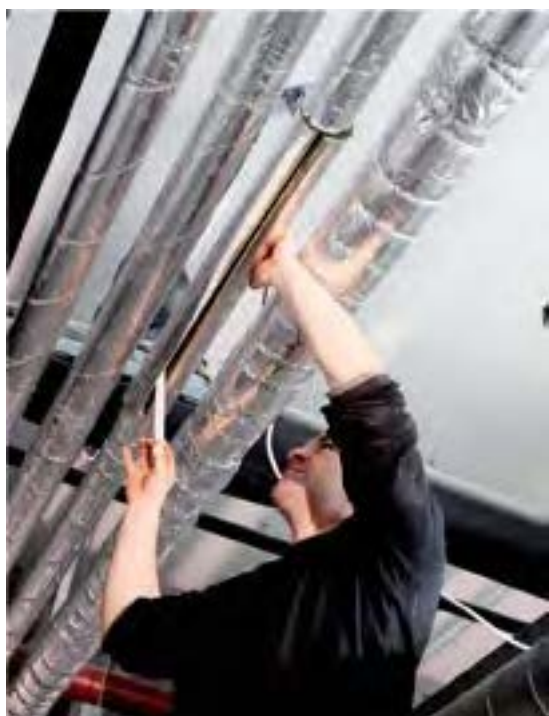
Montage der ROCKWOOL 800 an Heizungs- und Trinkwasserleitungen
